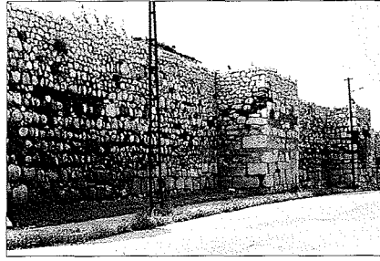
Çorum Kalesi'ne ait surlardan bir görünüşü
